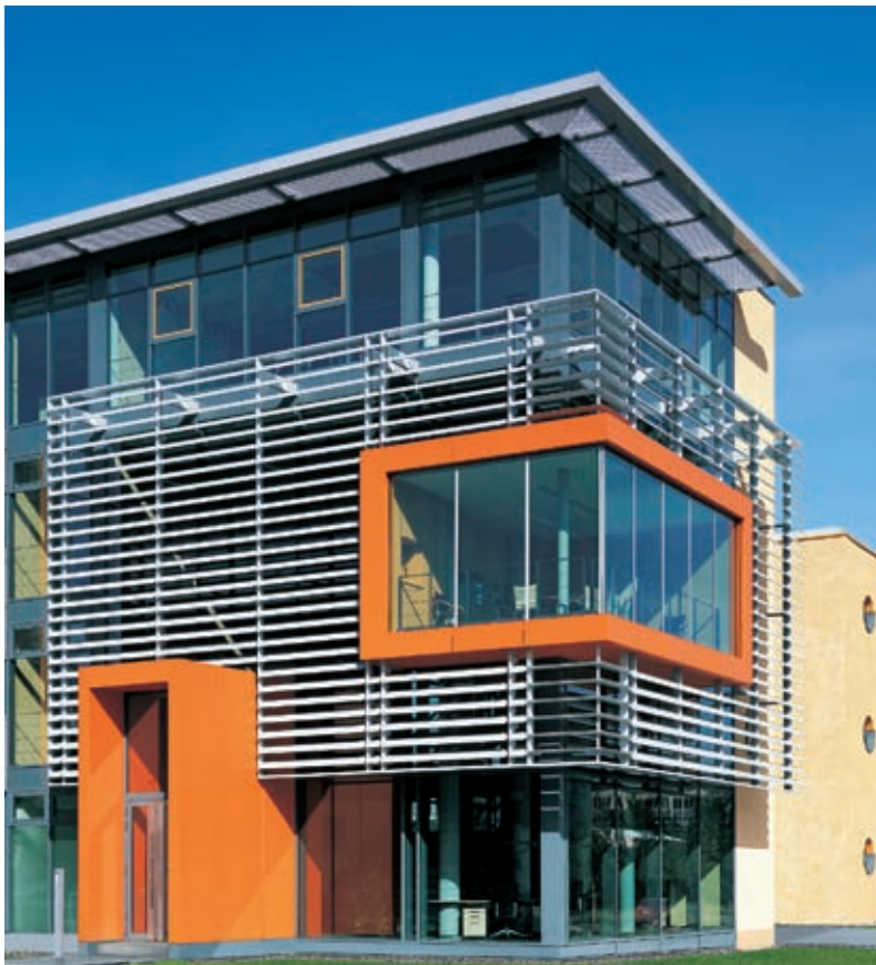
Neubau Handwerkskammer, Dresden, Deutschland Chamber of Crafts, Dresden, Germany
