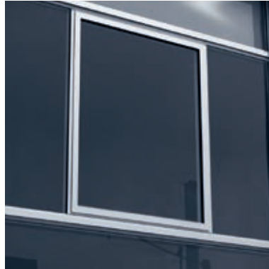
Schüco Fenster AWS als „schwimmendes Fenster“ Schüco Window AWS as "floating window"
